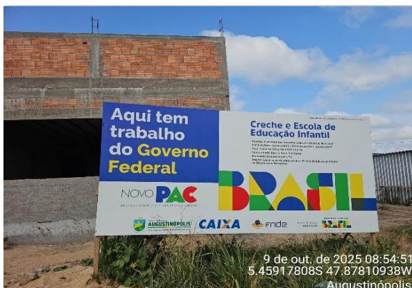
PLACA DE OBRA EM CHAPA GALVANIZADA CONSTRUÇÃO DE CRECHE E ESCOLA INFANTIL
