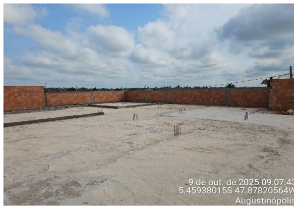
LAJE EM CONCRETO ARMADO CONSTRUÇÃO DE CRECHE E ESCOLA INFANTIL
