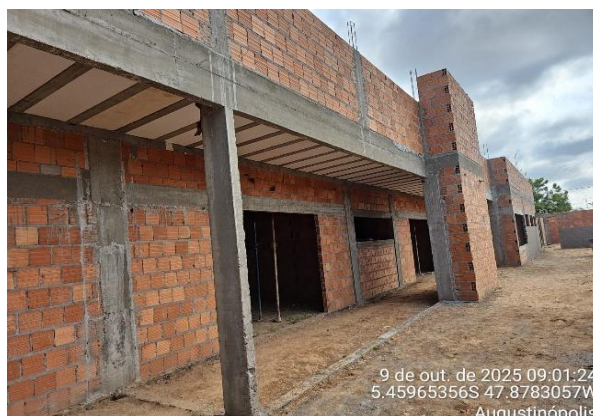
SUPERESTRUTURA E ALVENARIA DE VEDAÇÃO CONSTRUÇÃO DE CRECHE E ESCOLA INFANTIL
