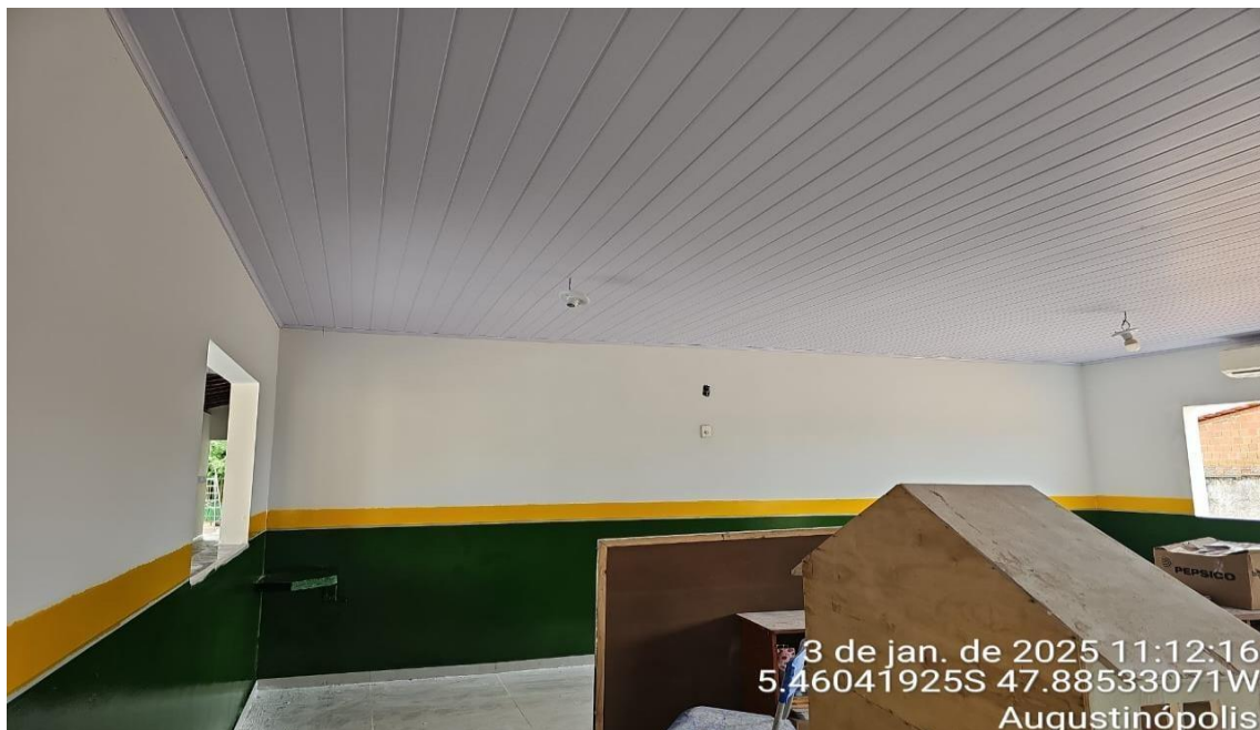
Figura 06 REFORMA E AMPLIAÇÃO DA ESCOLA GABRIEL ALVES
