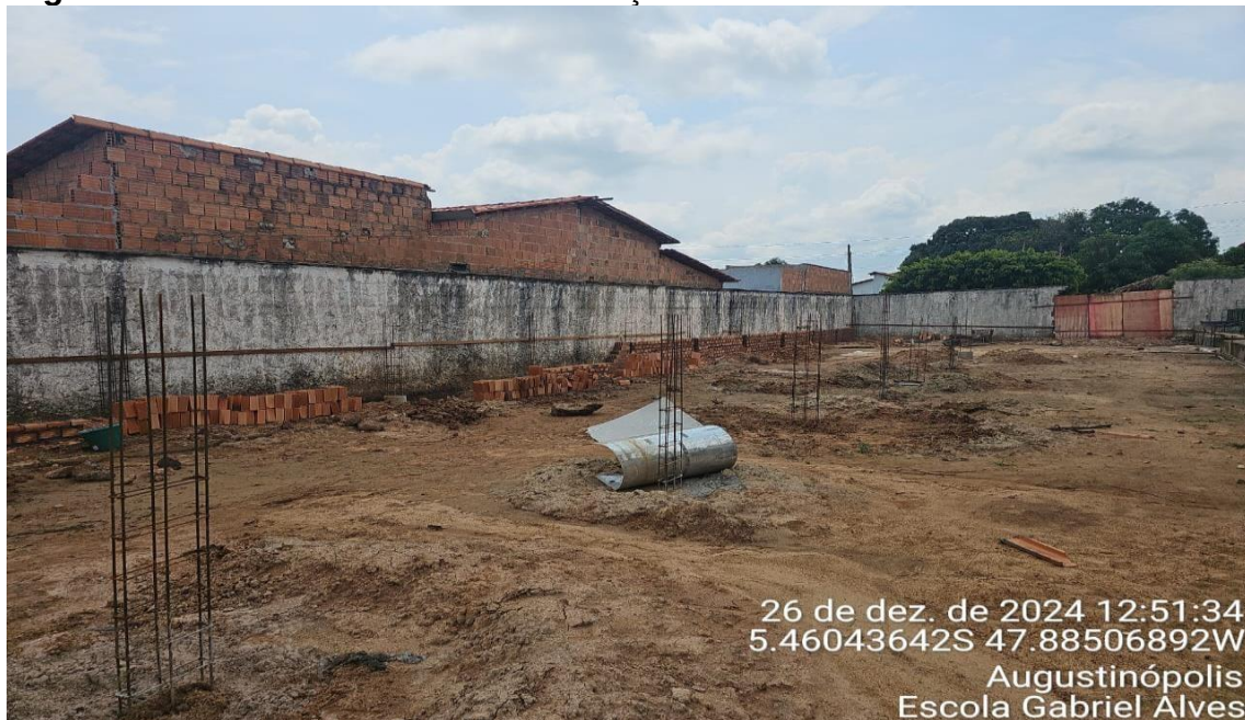
Figura 09 – REFORMA E AMPLIAÇÃO DA ESCOLA GABRIEL ALVES
