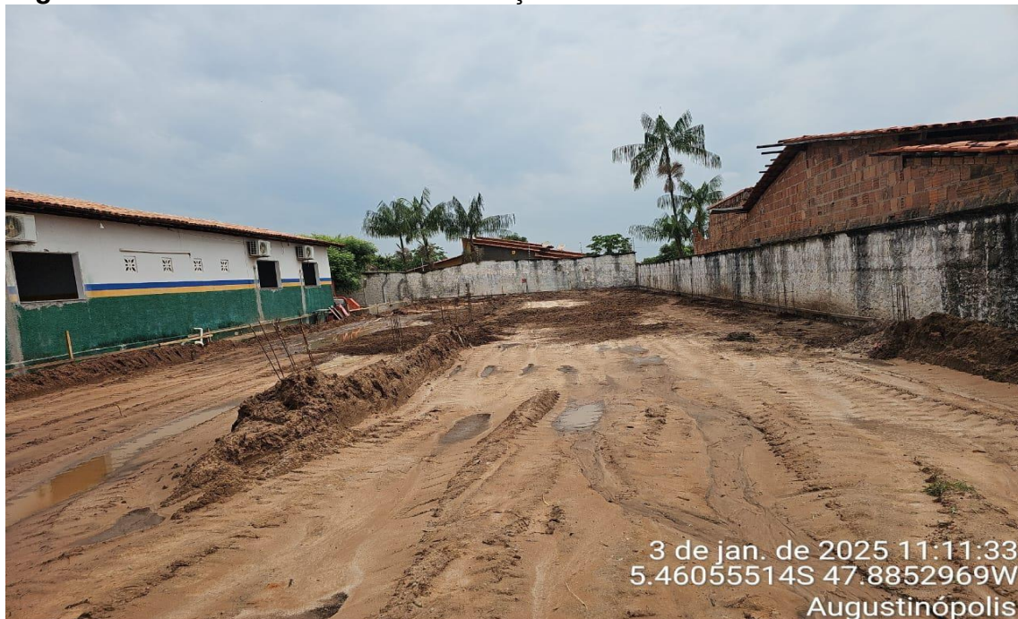
Figura 05 – REFORMA E AMPLIAÇÃO DA ESCOLA GABRIEL ALVES
