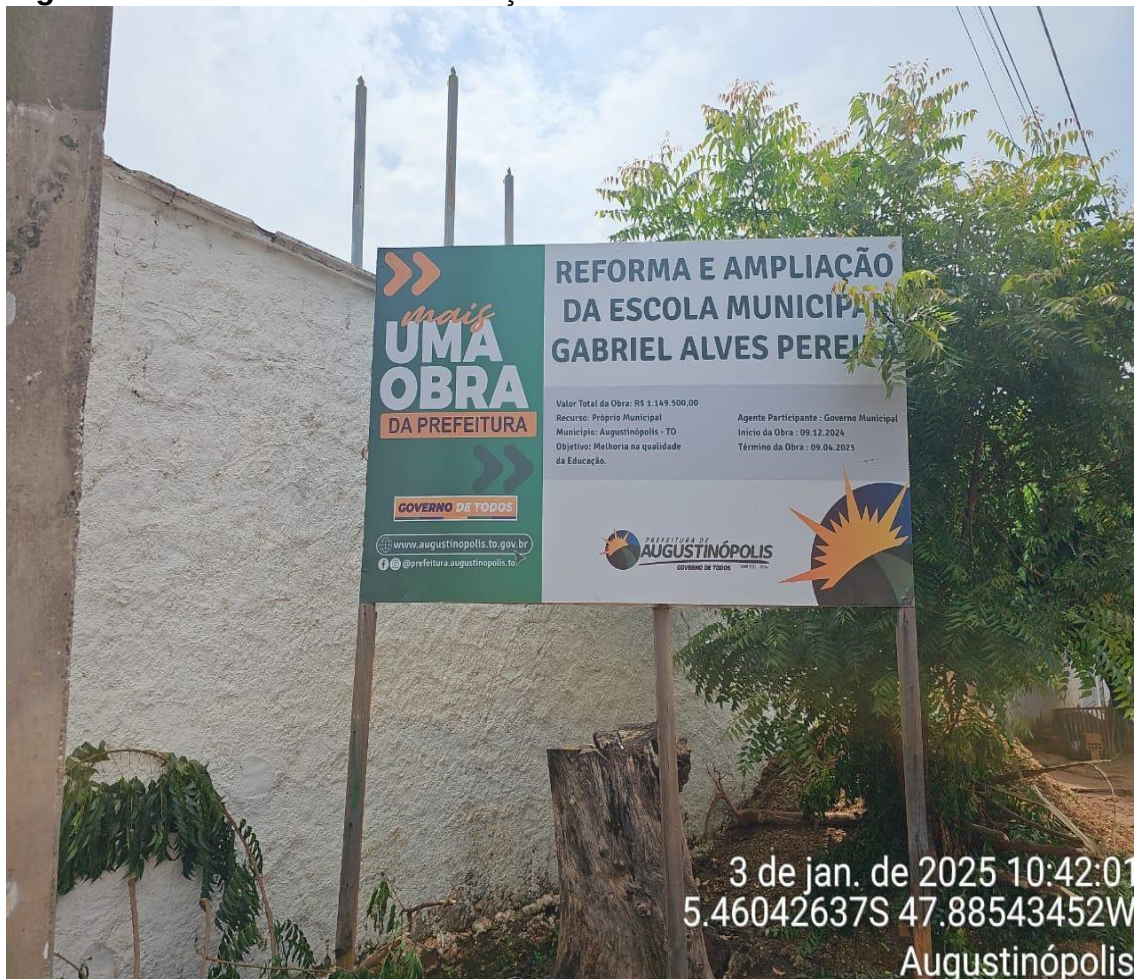
Figura 01 – REFORMA E AMPLIAÇÃO DA ESCOLA GABRIEL ALVES
