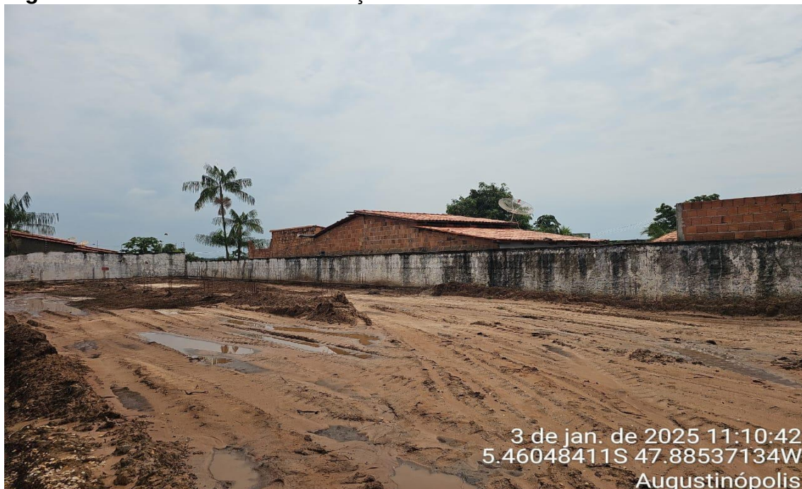
Figura 04 – REFORMA E AMPLIAÇÃO DA ESCOLA GABRIEL ALVES
