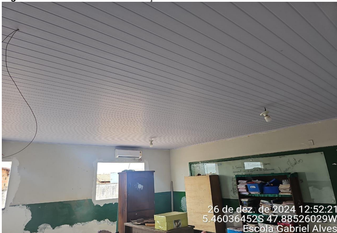
Figura 08 – REFORMA E AMPLIAÇÃO DA ESCOLA GABRIEL ALVES
