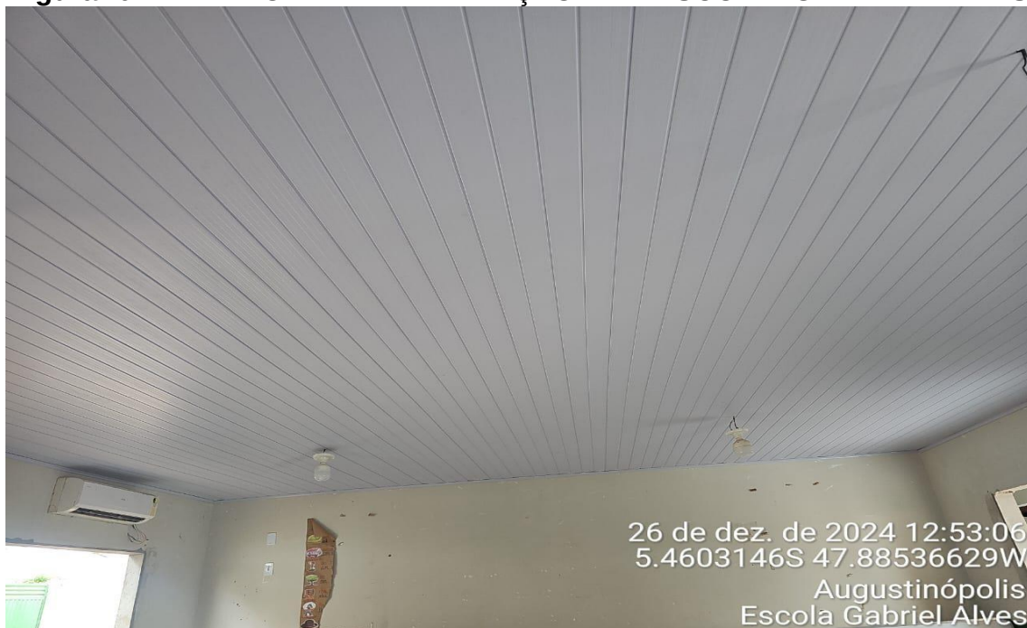
Figura 07 – REFORMA E AMPLIAÇÃO DA ESCOLA GABRIEL ALVES
