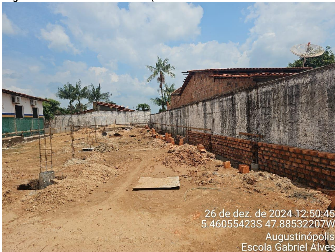
Figura 10 – REFORMA E AMPLIAÇÃO DA ESCOLA GABRIEL ALVES
