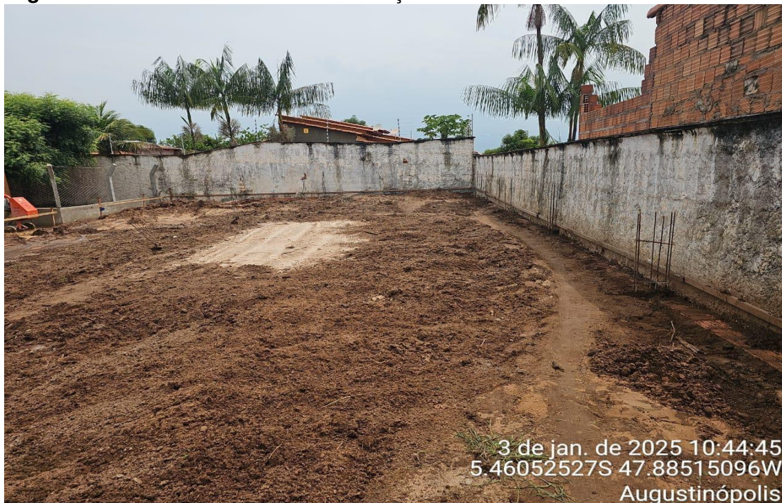
Figura 03 – REFORMA E AMPLIAÇÃO DA ESCOLA GABRIEL ALVES
