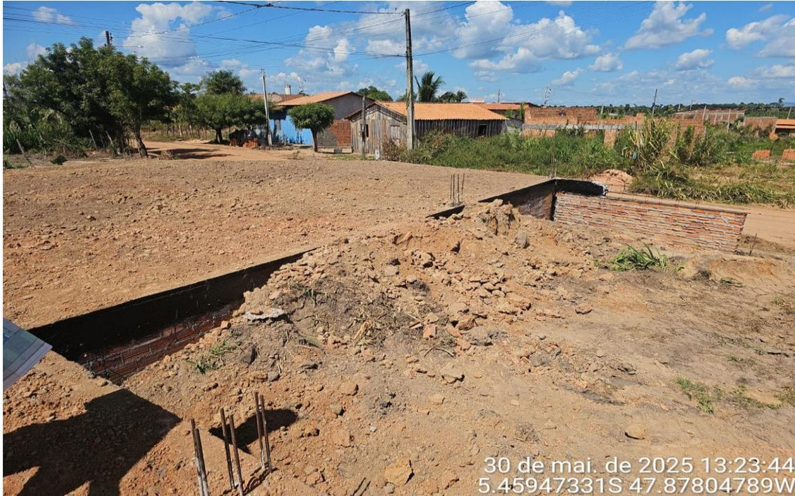
VIGA BALDRAME EXECUTADO, PILARES E FUNDAÇÃO
