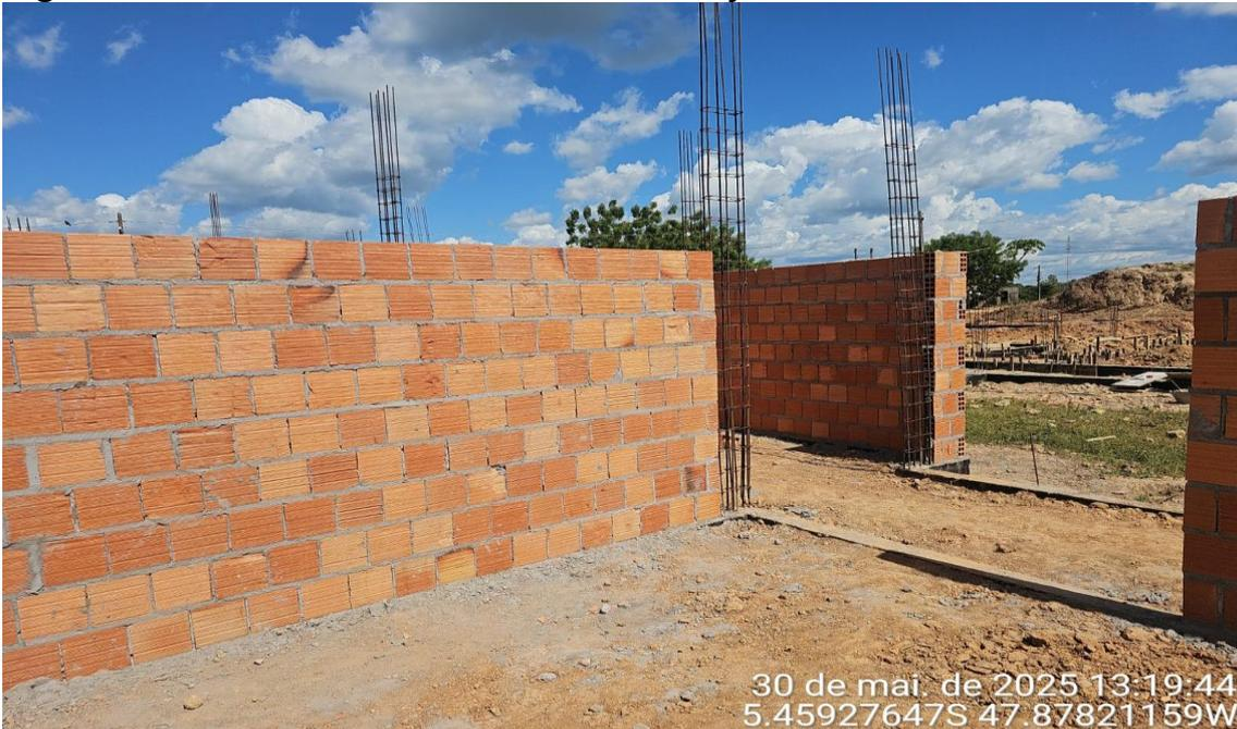
**CONCRETAGEM DE PILARES E LEVANTE DE ALVENARIA EM ANDAMENTO**
