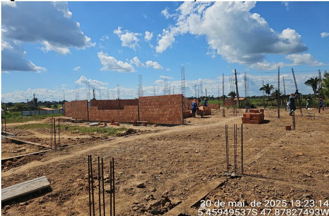
FUNDAÇÃO COM SAPATAS E ARRANQUES DE PILARES EXECUTADOS
