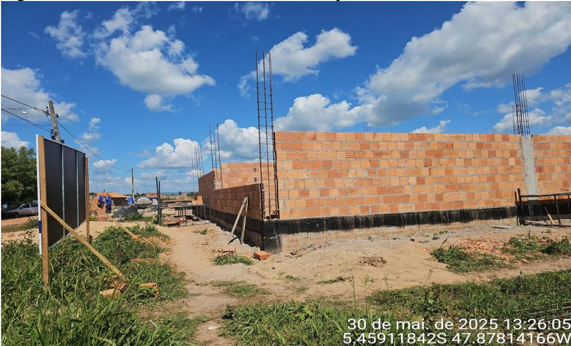
**SUPERESTRUTURA EM ANDAMENTO, CONCRETAGEM DE PILARES E LEVANTE DE ALVENARIA**
