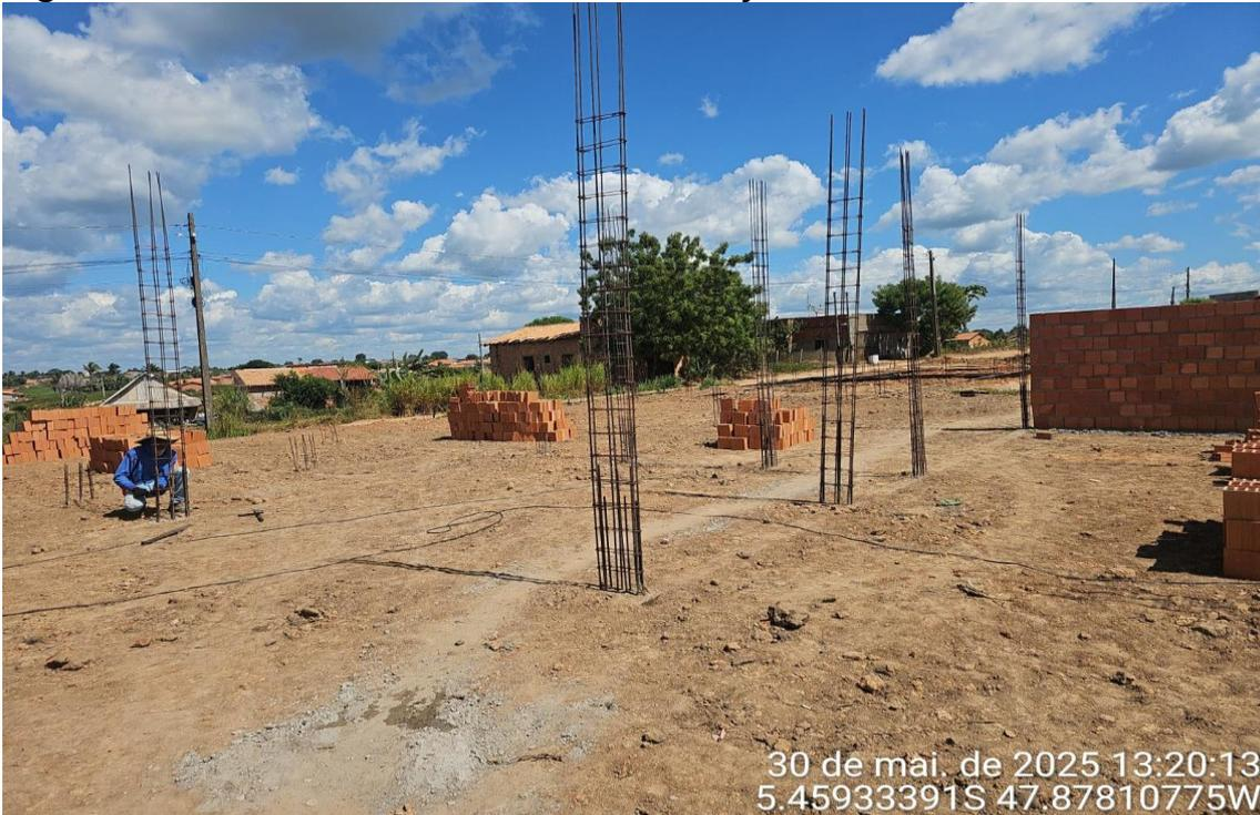
FUNDAÇÃO COM SAPATAS E ARRANQUES DE PILARES EXECUTADOS
