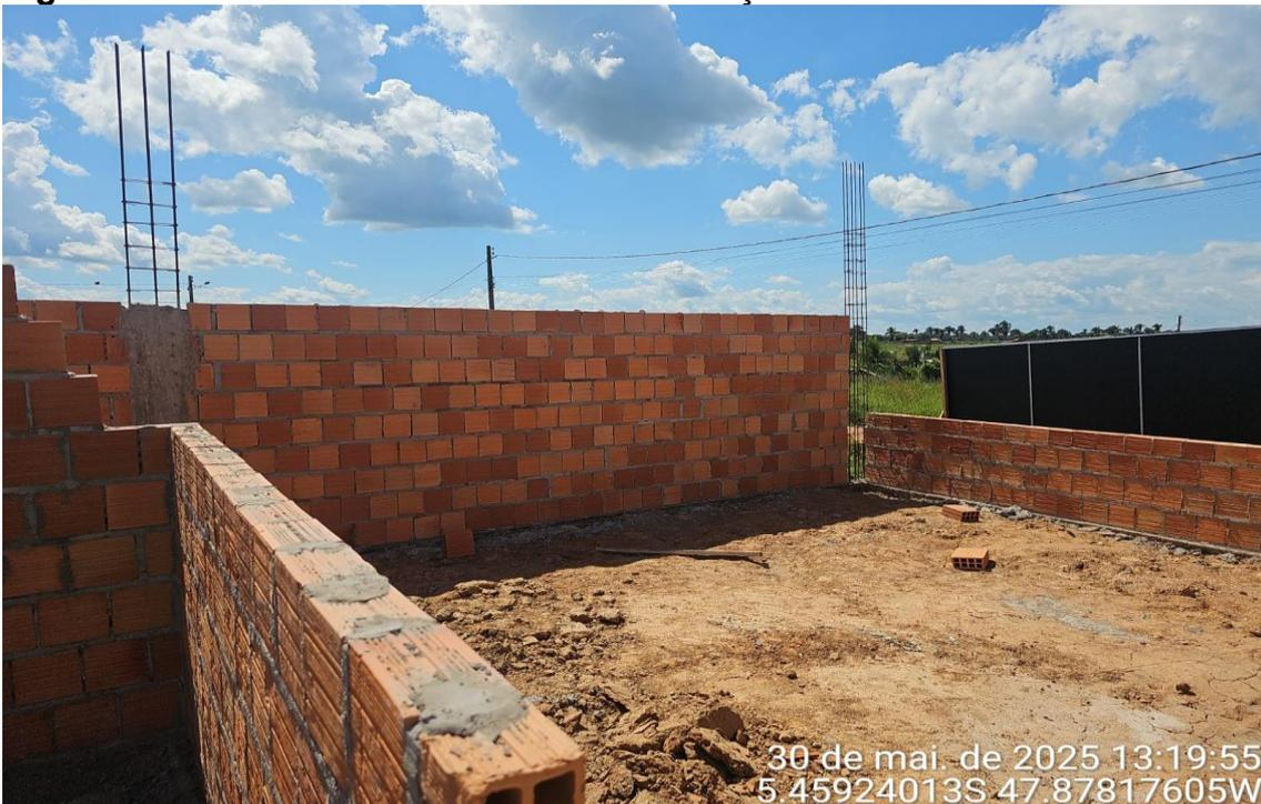
**CONCRETAGEM DE PILARES E LEVANTE DE ALVENARIA EM ANDAMENTO**
