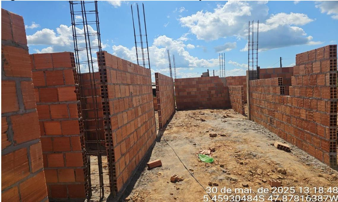
**CONCRETAGEM DE PILARES E LEVANTE DE ALVENARIA EM ANDAMENTO**
