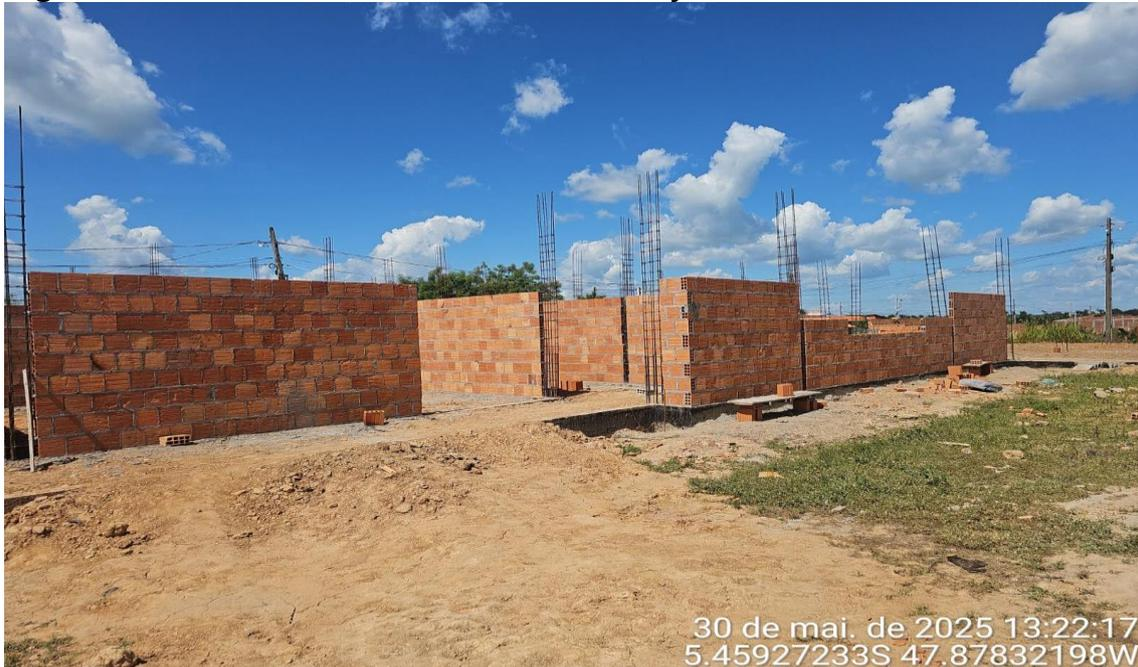
**SUPERESTRUTURA EM ANDAMENTO, CONCRETAGEM DE PILARES E LEVANTE DE ALVENARIA**
