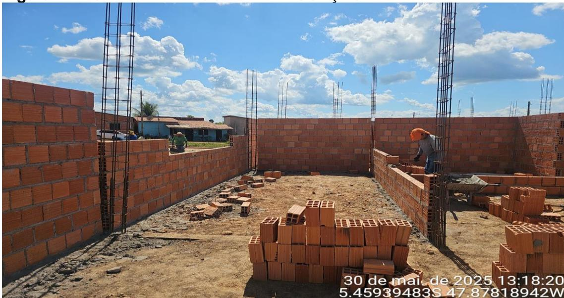
**CONCRETAGEM DE PILARES E LEVANTE DE ALVENARIA EM ANDAMENTO**
