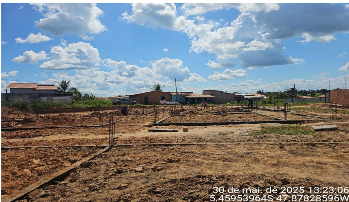
FUNDAÇÃO COM SAPATAS E ARRANQUES EXECUTADOS
