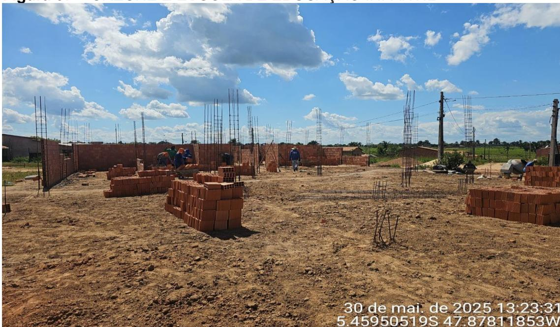
FUNDAÇÃO COM SAPATAS E ARRANQUES DE PILARES EXECUTADOS
