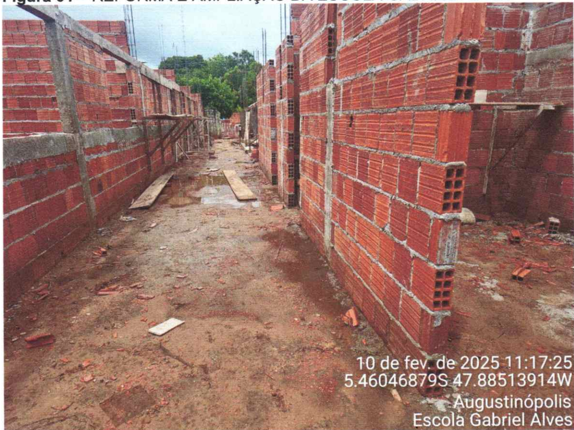
Figura 01 – REFORMA E AMPLIAÇÃO DA ESCOLA GABRIEL ALVES
