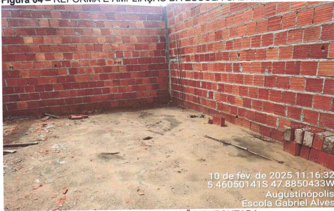
Figura 04 – REFORMA E AMPLIAÇÃO DA ESCOLA GABRIEL ALVES
