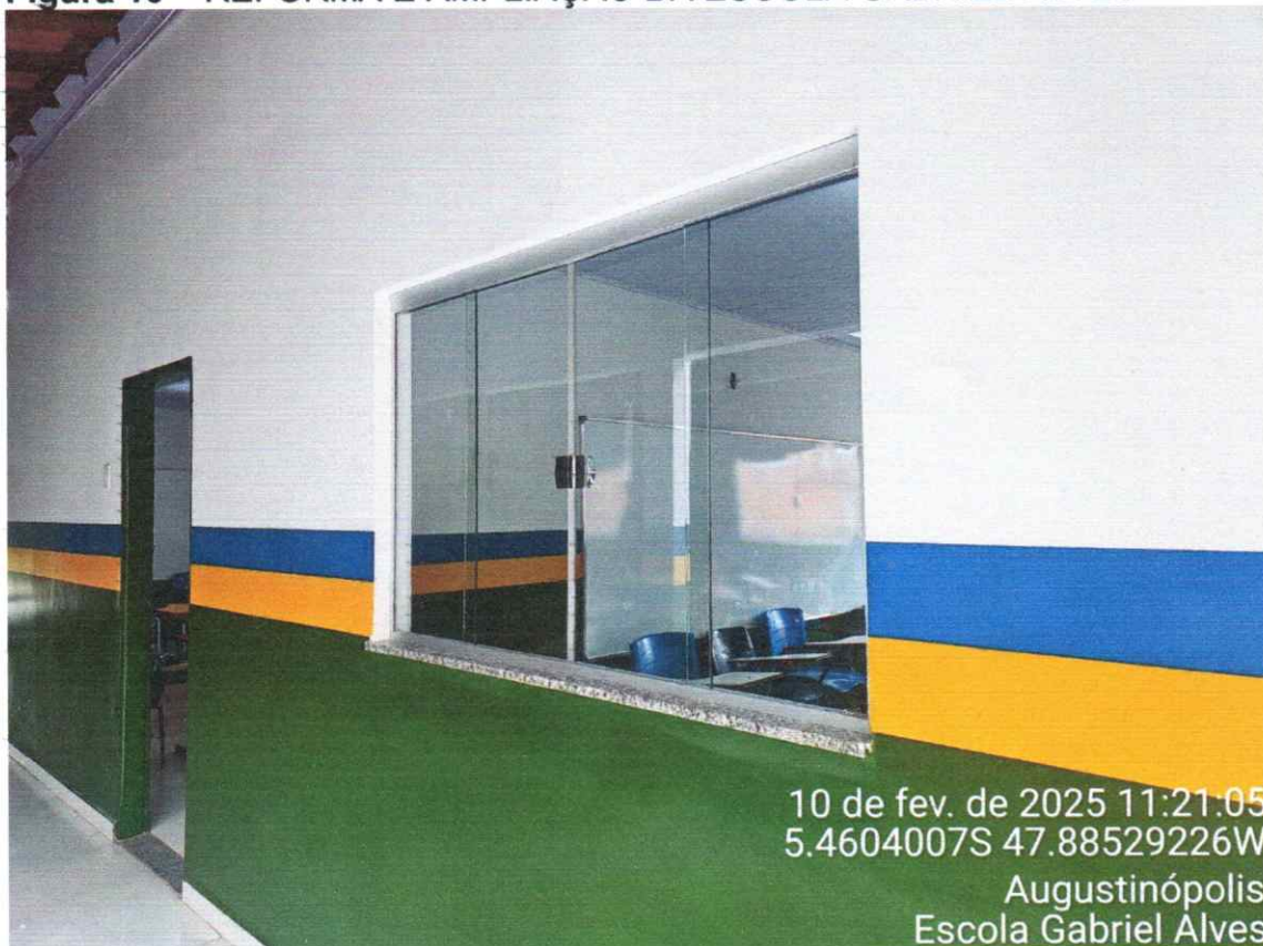
Figura 10 – REFORMA E AMPLIAÇÃO DA ESCOLA GABRIEL ALVES
