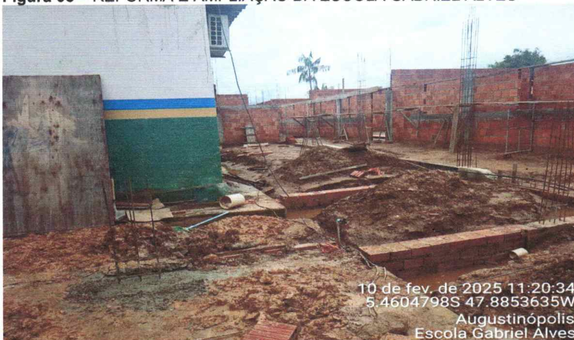
Figura 03 – REFORMA E AMPLIAÇÃO DA ESCOLA GABRIEL ALVES
