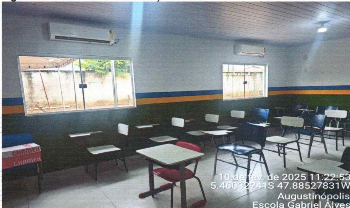
Figura 08 – REFORMA E AMPLIAÇÃO DA ESCOLA GABRIEL ALVES
