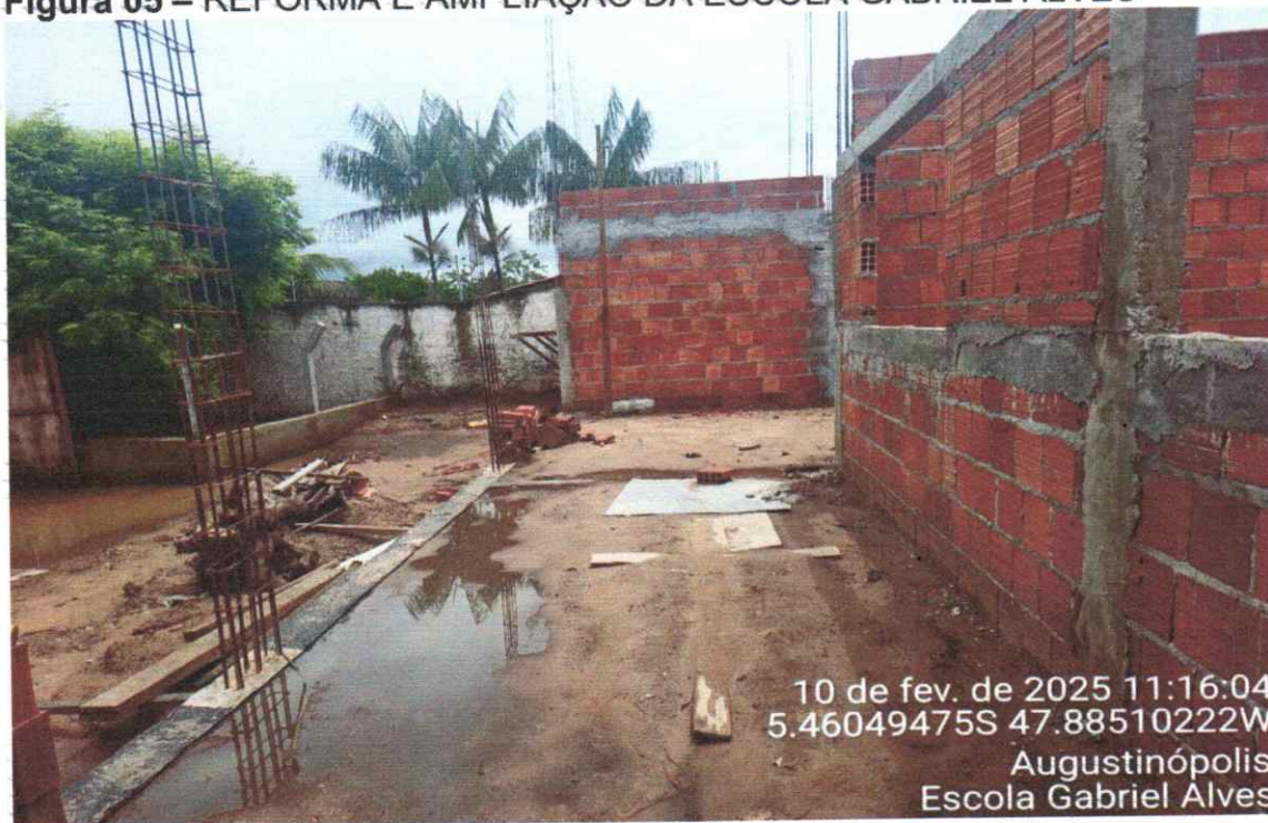
Figura 05 – REFORMA E AMPLIAÇÃO DA ESCOLA GABRIEL ALVES
