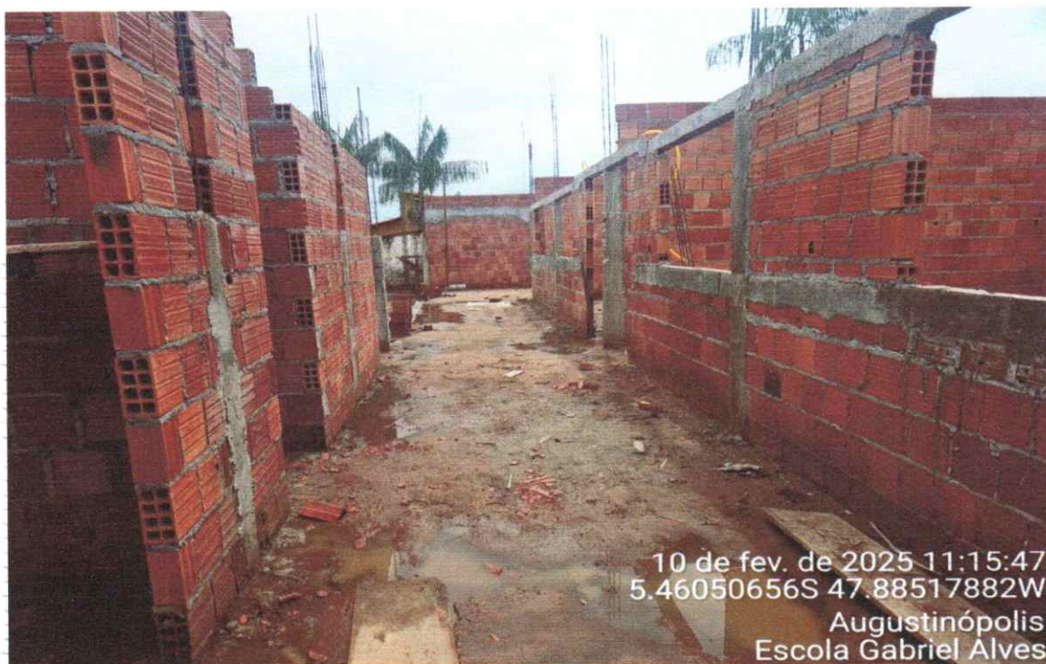
Figura 06 REFORMA E AMPLIAÇÃO DA ESCOLA GABRIEL ALVES
