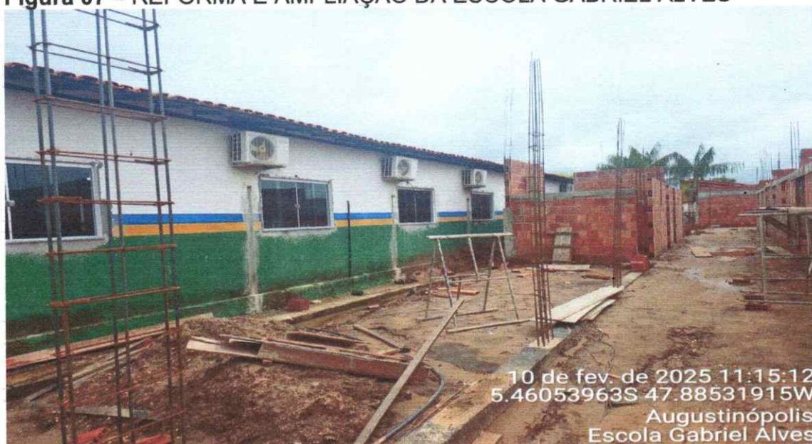
Figura 07 – REFORMA E AMPLIAÇÃO DA ESCOLA GABRIEL ALVES
