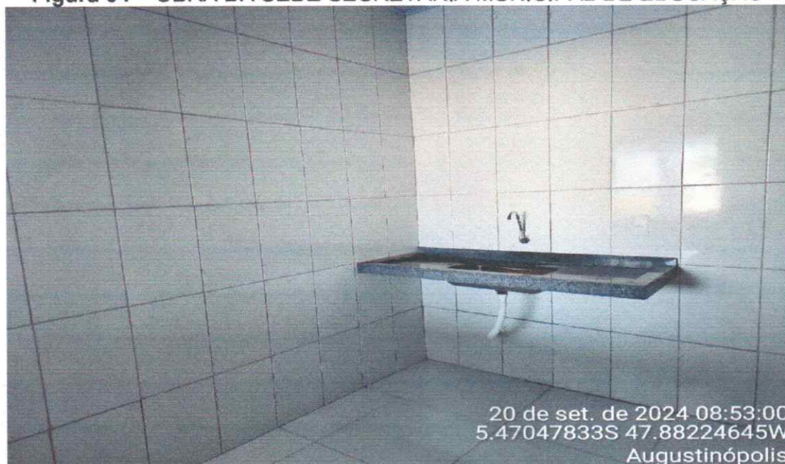
Figura 04 – OBRA DA SEDE SECRETARIA MUNICIPAL DE EDUCAÇÃO
