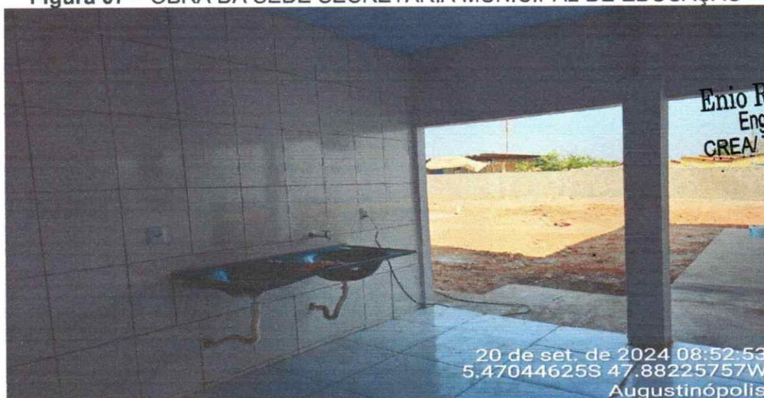
Figura 07 – OBRA DA SEDE SECRETARIA MUNICIPAL DE EDUCAÇÃO
