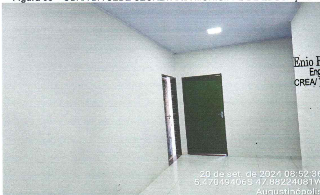
Figura 05 – OBRA DA SEDE SECRETARIA MUNICIPAL DE EDUCAÇÃO
