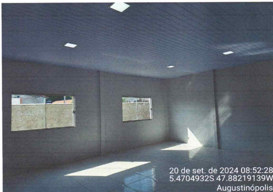
Figura 06 – OBRA DA SEDE SECRETARIA MUNICIPAL DE EDUCAÇÃO
