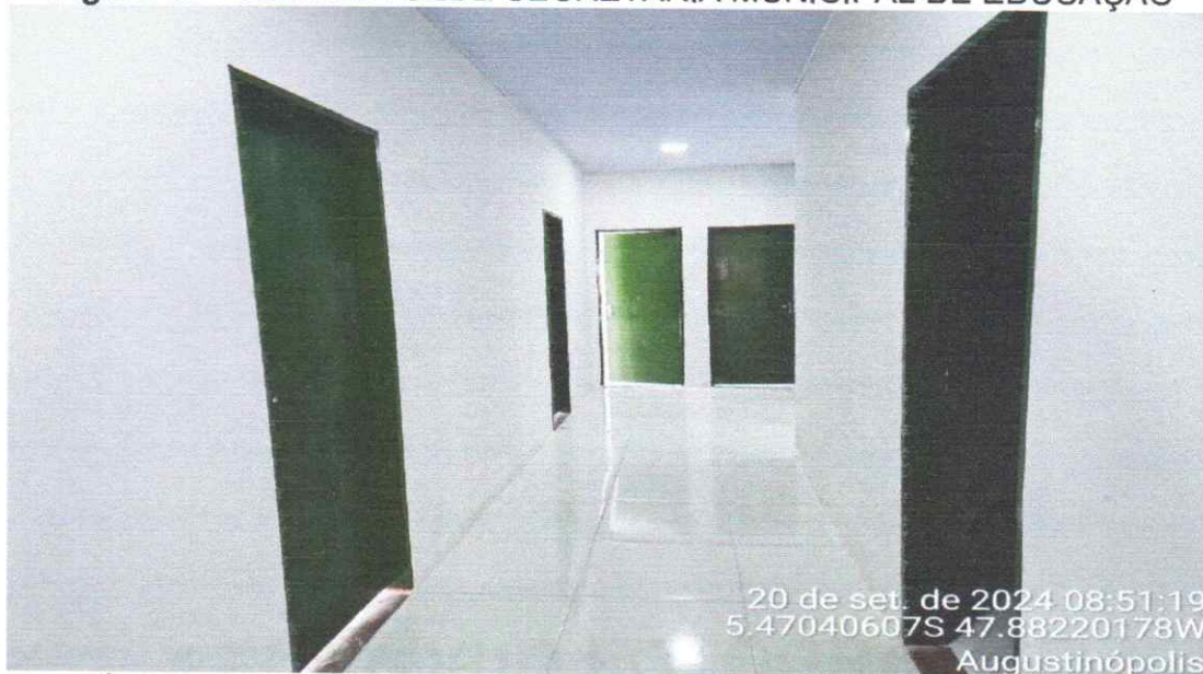
Figura 08 – OBRA DA SEDE SECRETARIA MUNICIPAL DE EDUCAÇÃO
