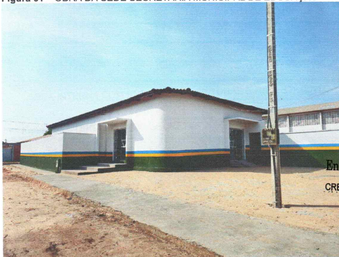
Figura 01 – OBRA DA SEDE SECRETARIA MUNICIPAL DE EDUCAÇÃO
