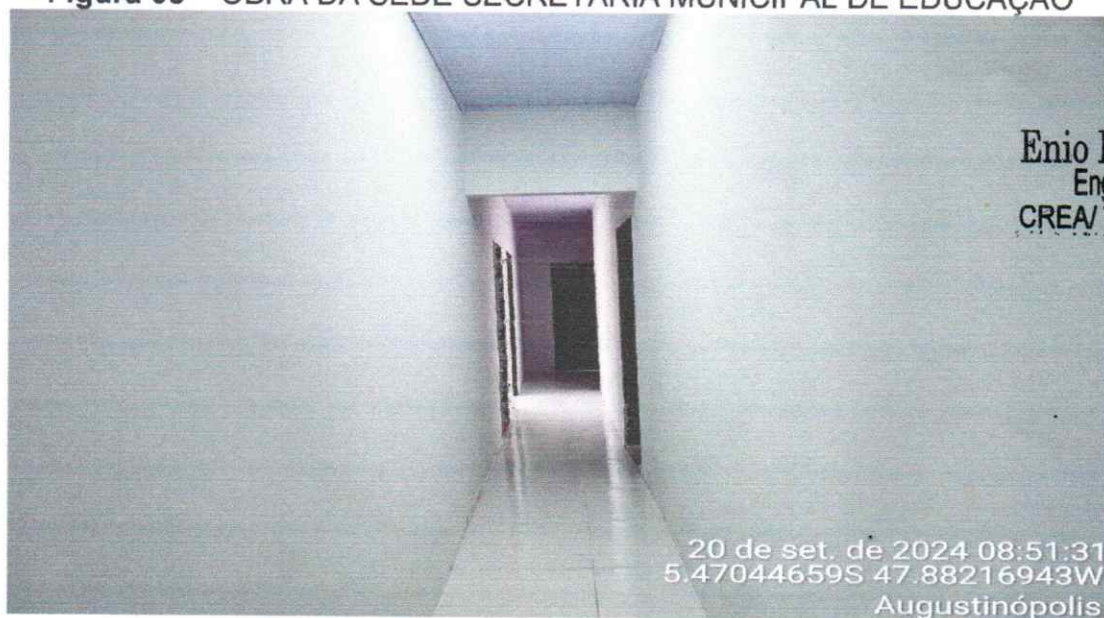
Figura 08 – OBRA DA SEDE SECRETARIA MUNICIPAL DE EDUCAÇÃO
