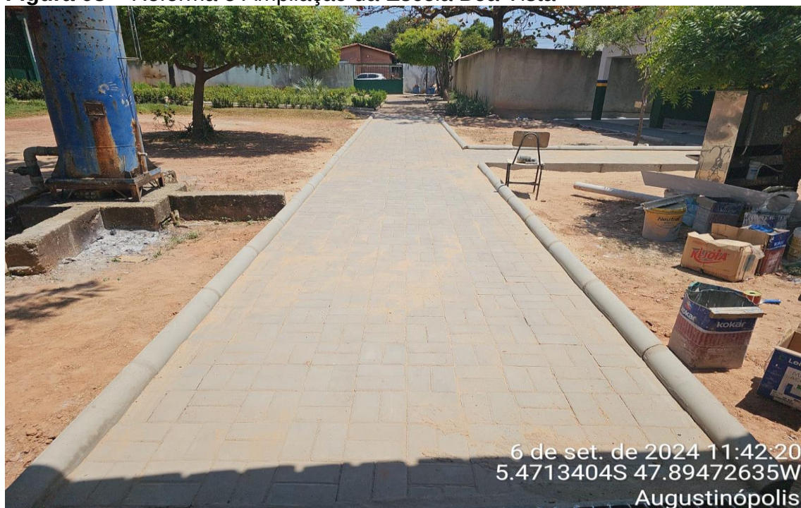
CALÇADA EM BLOCOS INTERTRAVADOS EM AREA EXTERNA
