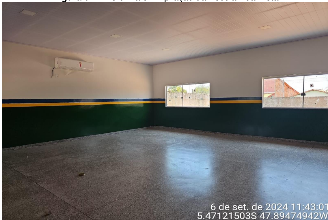
Figura 02 – Reforma e Ampliação da Escola Boa Vista
