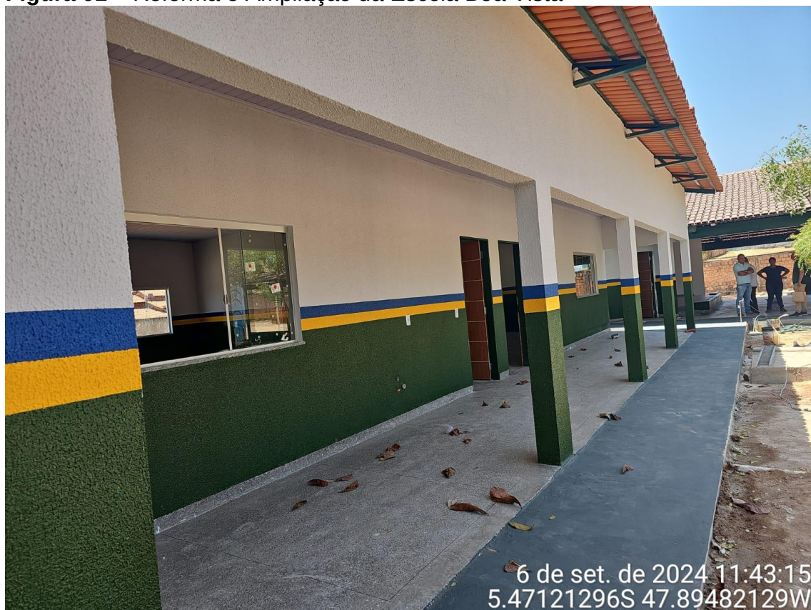
Figura 01 – Reforma e Ampliação da Escola Boa Vista
