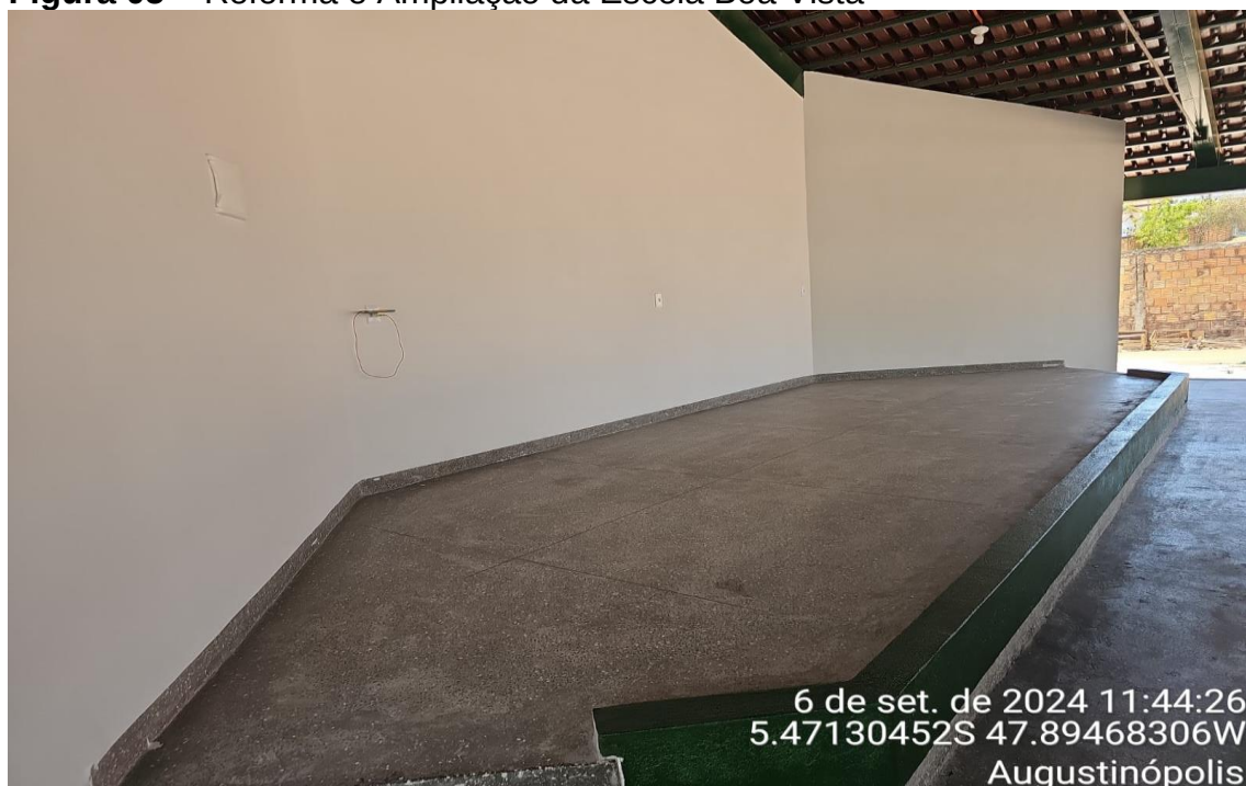
Figura 05 – Reforma e Ampliação da Escola Boa Vista
