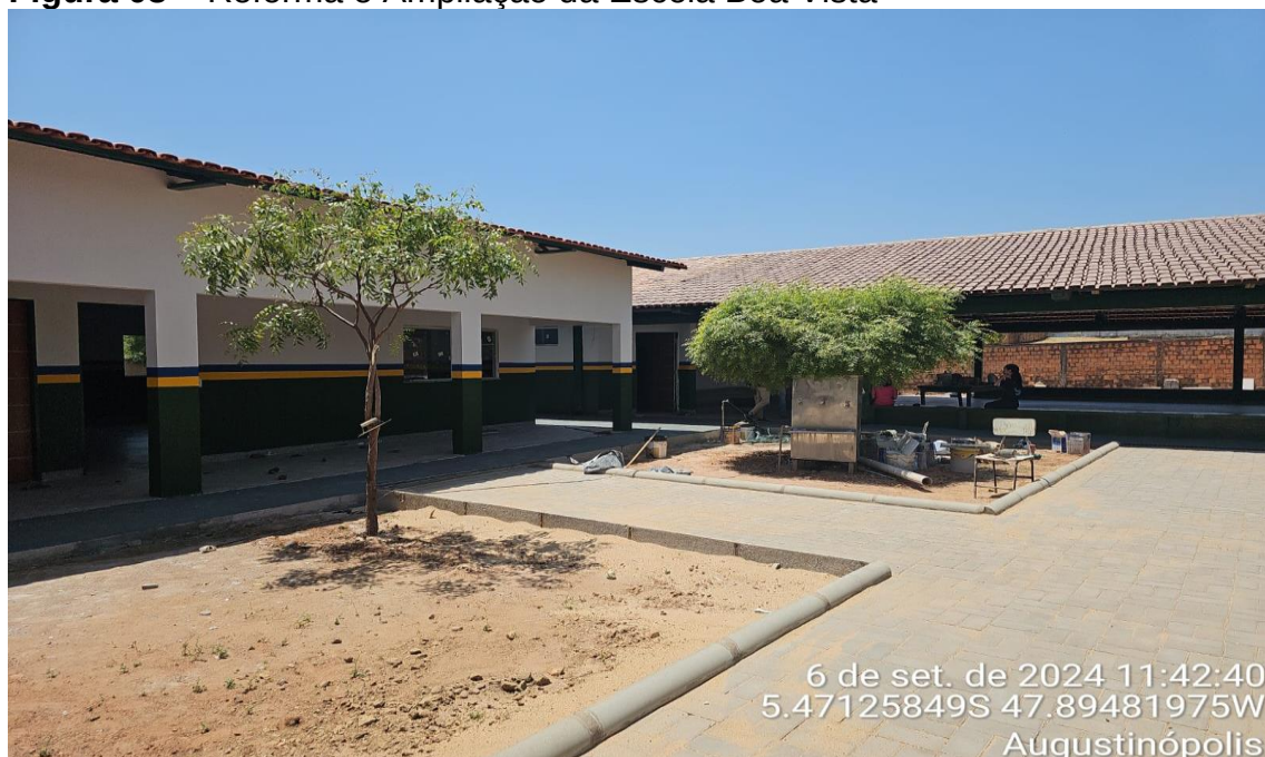
Figura 03 – Reforma e Ampliação da Escola Boa Vista
