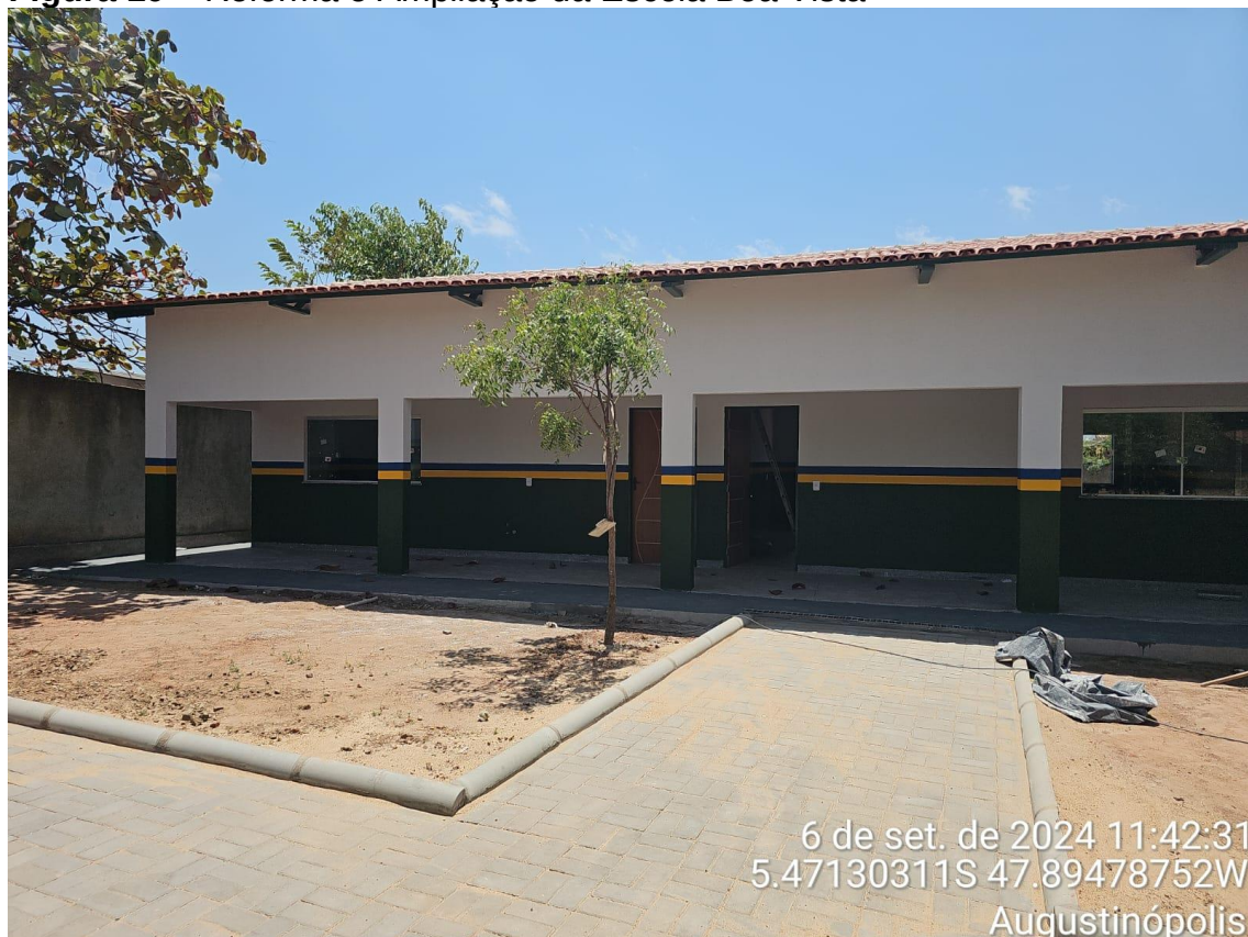
Figura 10 – Reforma e Ampliação da Escola Boa Vista
