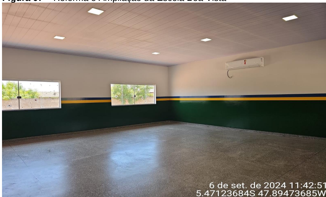
Figura 07 – Reforma e Ampliação da Escola Boa Vista
