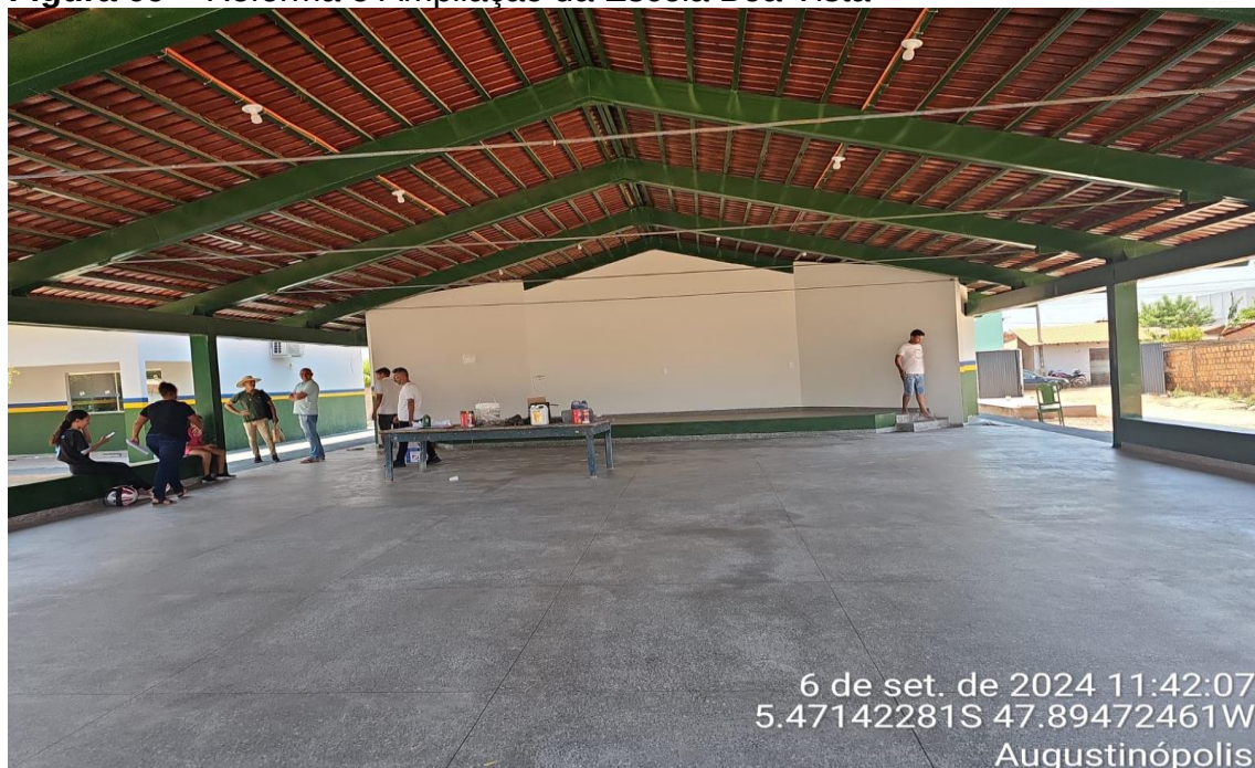
AREA COM SERVIÇOS 100% EXECUTADOS, PINTURA, COBERTURA, PISO GRANILITE E ESTRUTURA METALICA.
