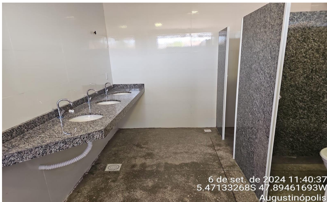
Figura 06 Reforma e Ampliação da Escola Boa Vista
