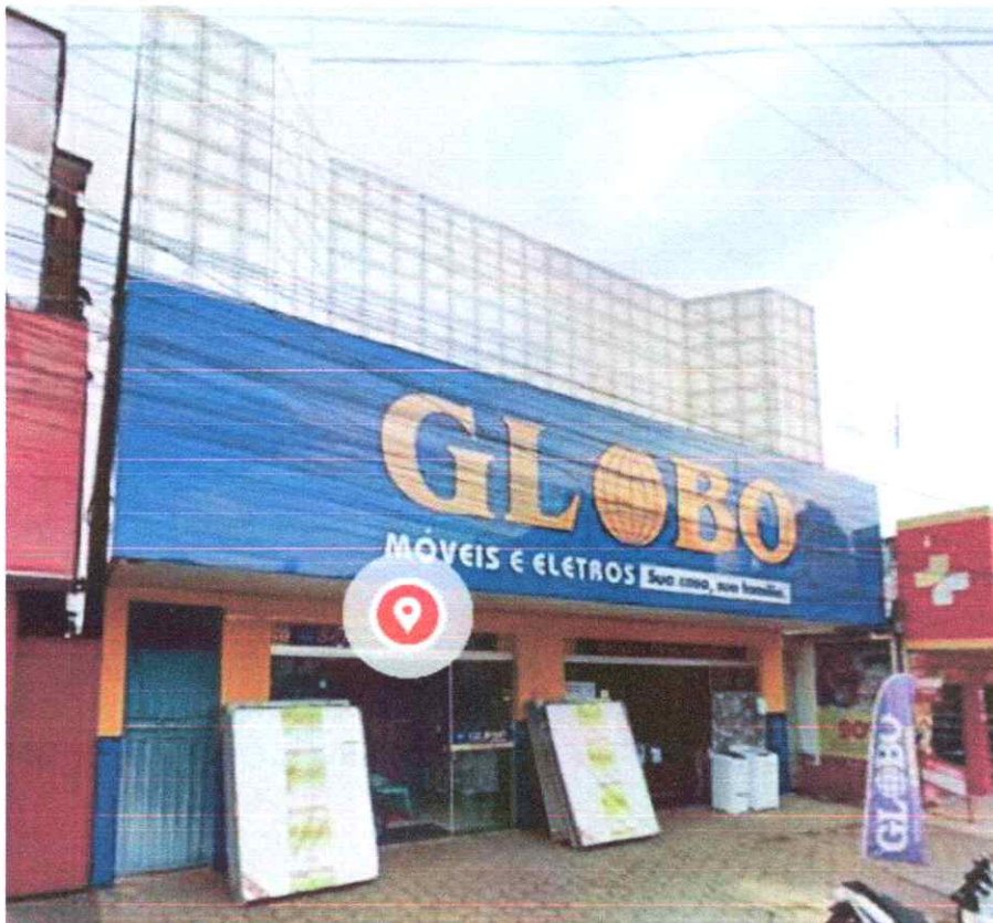
Figura 02: Fachada externa do imóvel.
