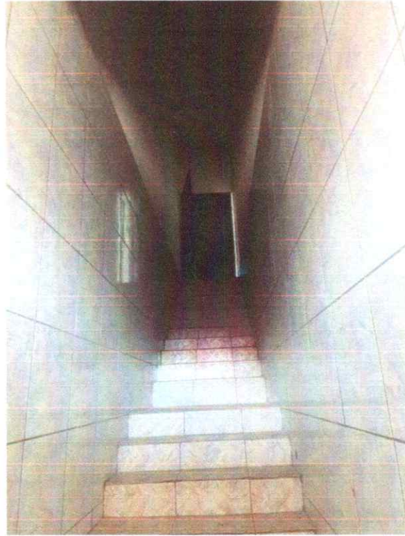
Figura 03: Acesso ao piso superior do imóvel.
