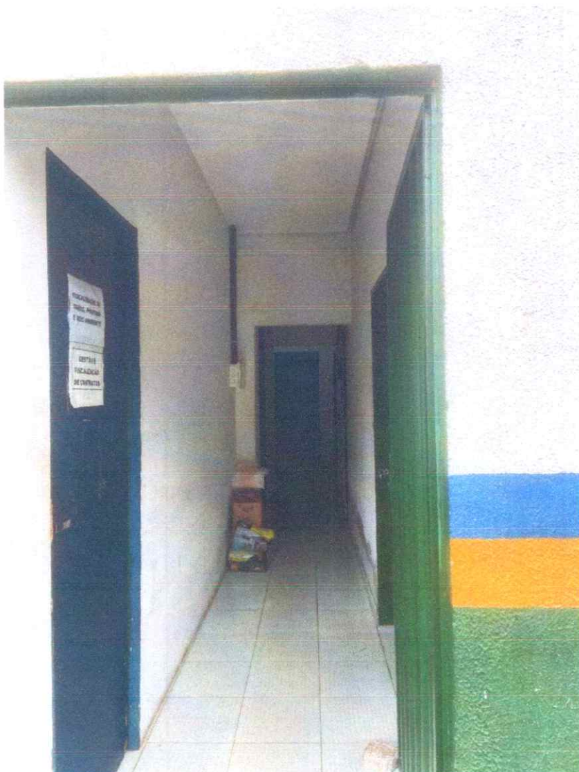
Figura 03: foto interna do imóvel.
