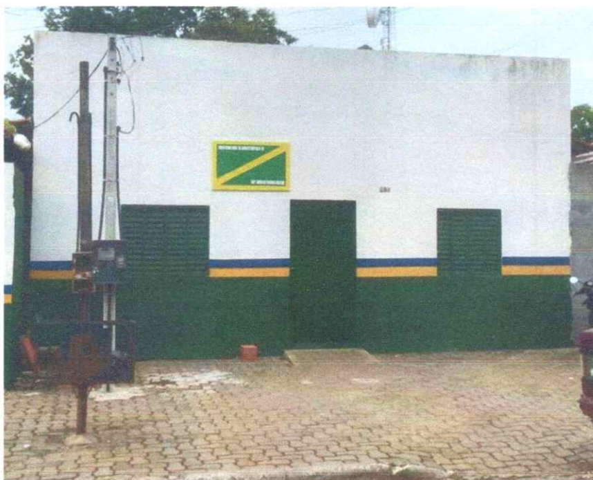
Figura 02: Fachada externa do imóvel.
