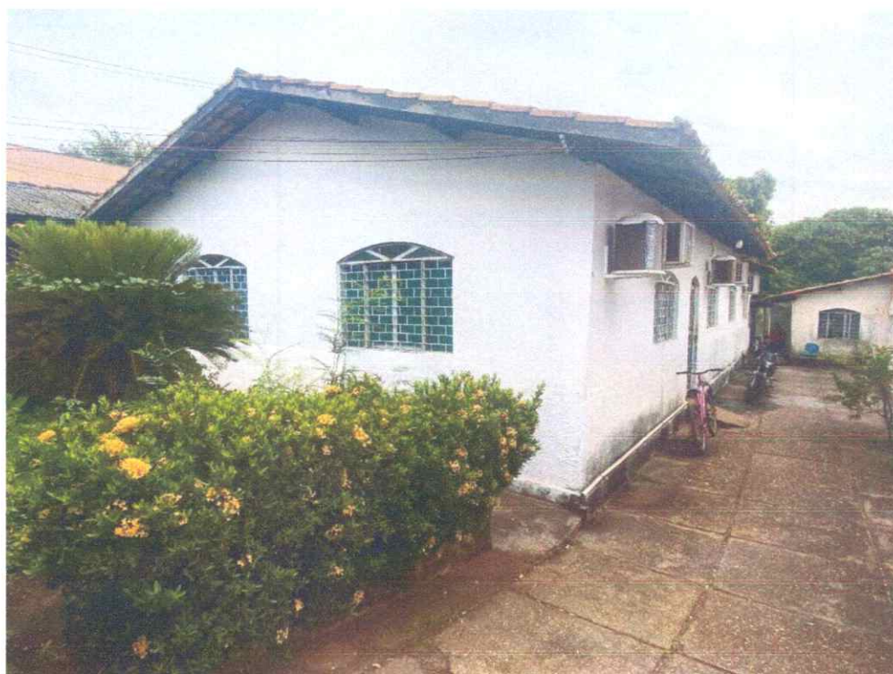
Figura 03: Fachada frontal do imóvel
