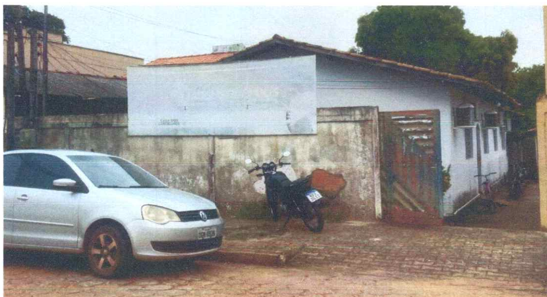
Figura 02: Fachada externa do imóvel.
