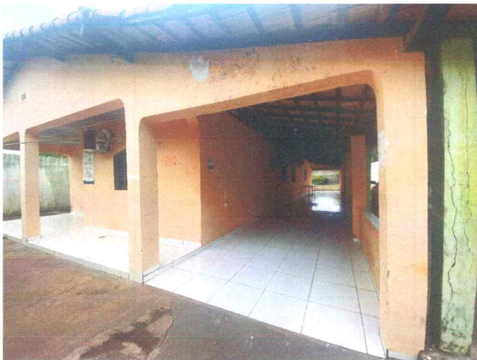
Figura 03: Fachada frontal do imóvel
