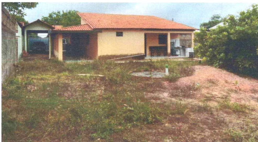
Figura 04: Fachada posterior do imóvel.
