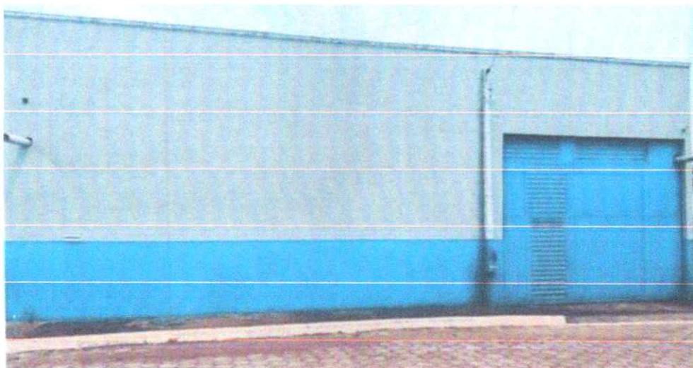
Figura 02: Fachada externa do imóvel.
