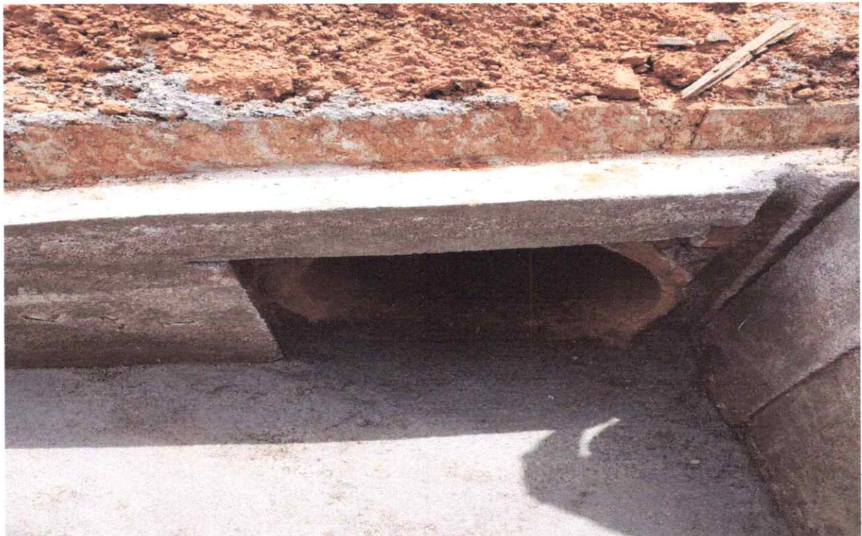
Bueiro simples (RUA TANCREDO NEVES)
