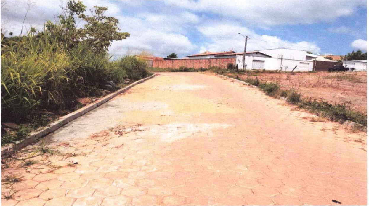
Pavimentação, Drenagem Superficial e profunda
