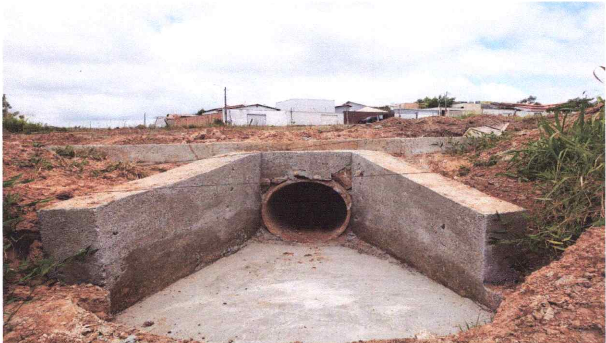
Bueiro simples (RUA TANCREDO NEVES)
