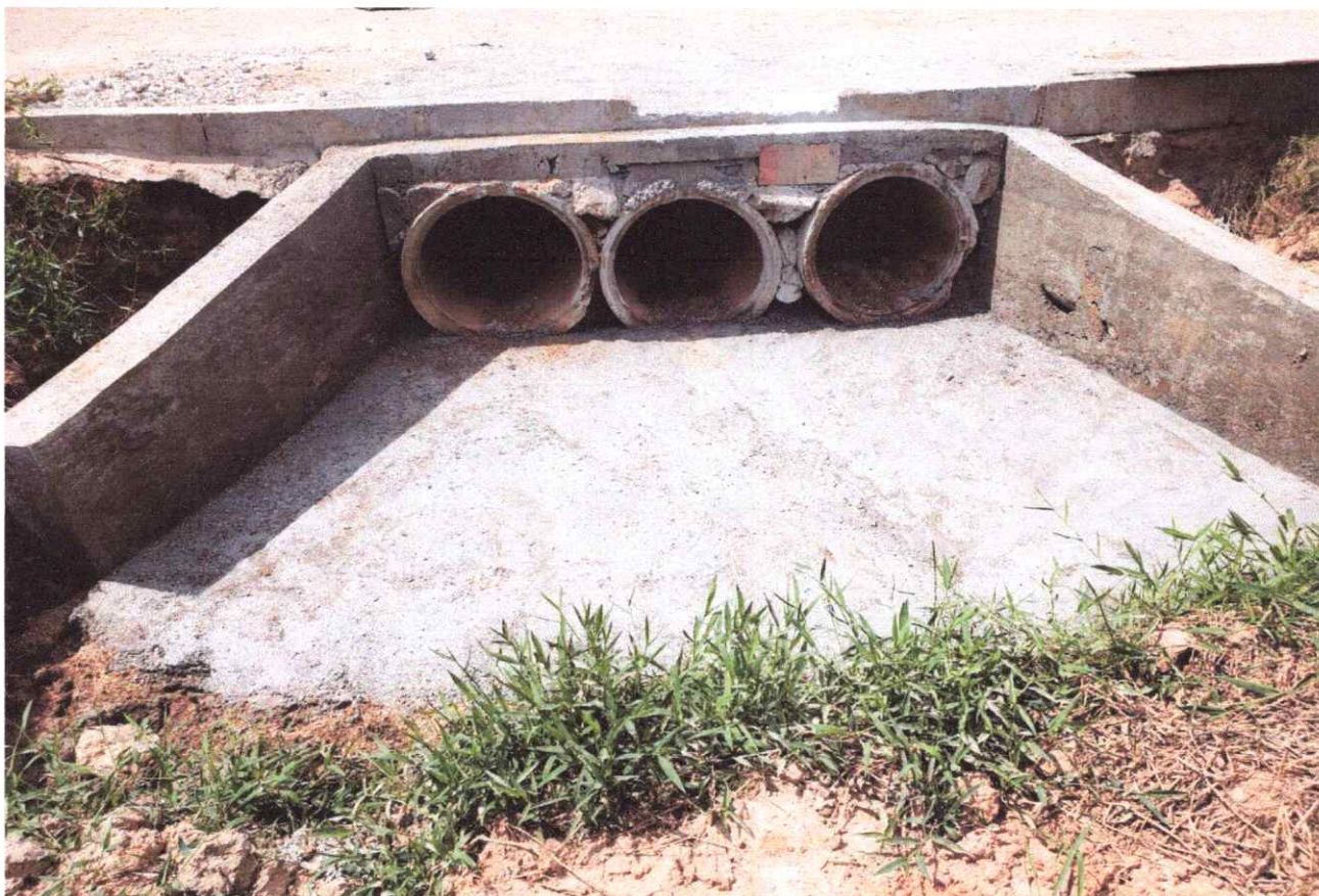
Bueiro Triplo ( RUA MATO GROSSO)
