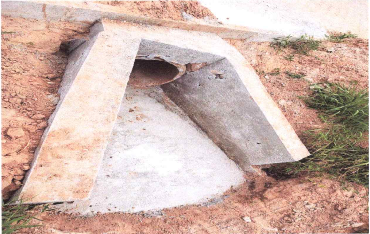
Bueiro simples (RUA TANCREDO NEVES)
